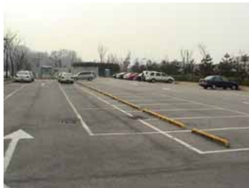
<사진 7> 주차장 차량을 분산시키고 구획내 주차를 돕는 철구조물
