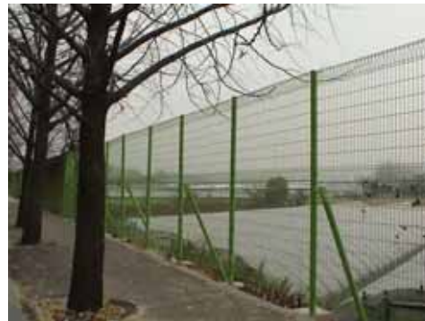
<사진 18> 아파트 남쪽경계를 따라서 설치된 철제 담
